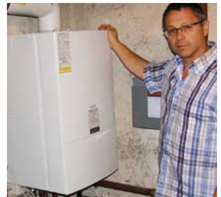
Bild oben: So sah der alte Heizkessel mit dem Ölbrenner aus.
