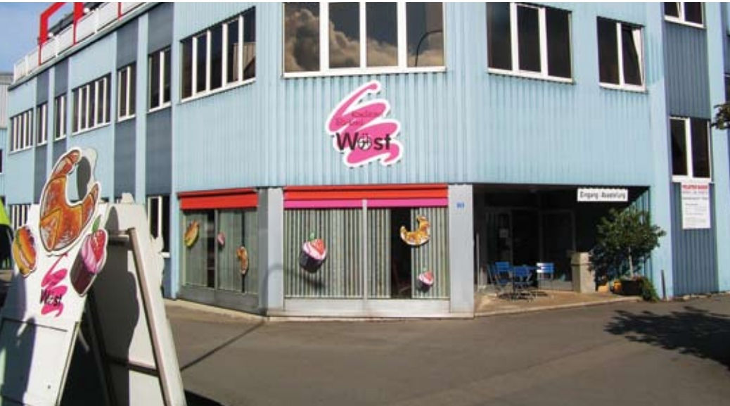
Die Bäckerei-Konditorei Wüst in Wangen konnte nun an das Erdgasnetz angeschlossen werden.
