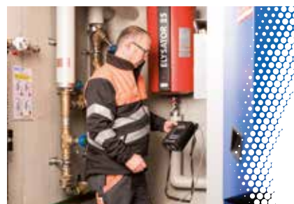
EZL | Eugen Steimen, Installationskontrolleur
