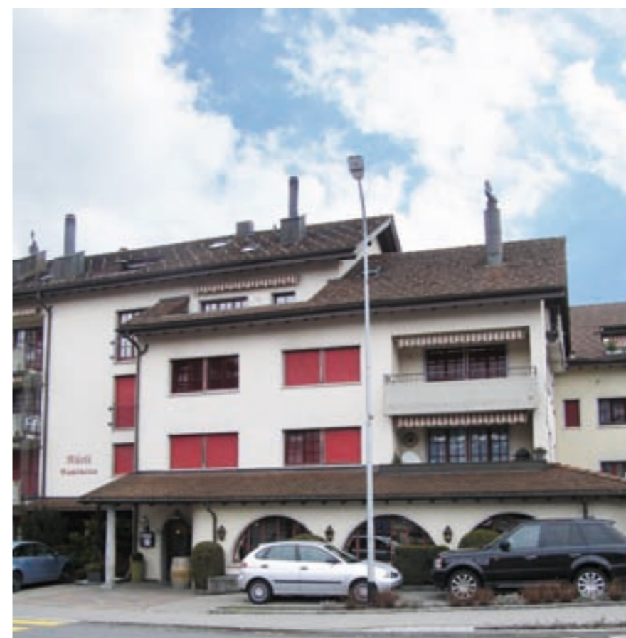
Auch die Liegenschaft an der Oberdorfstrasse 15 mit dem Ristorante Caminetto wurde auf Erdgas umgestellt.
