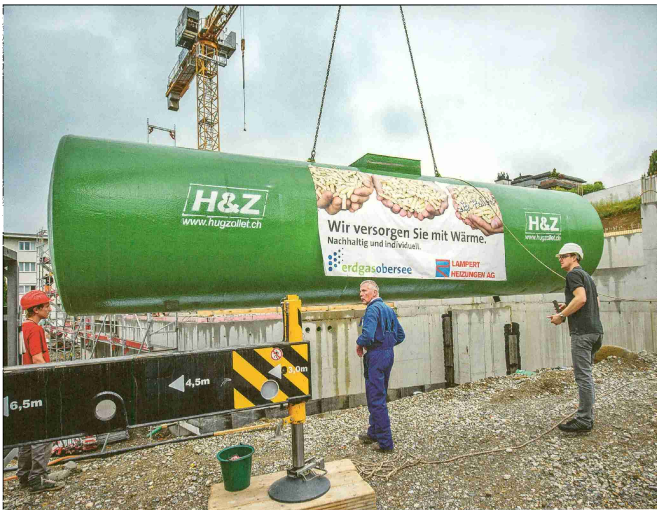
1–2 Arbeitsfortschritte, bis der Tank am vorgesehenen Ort platziert ist.
